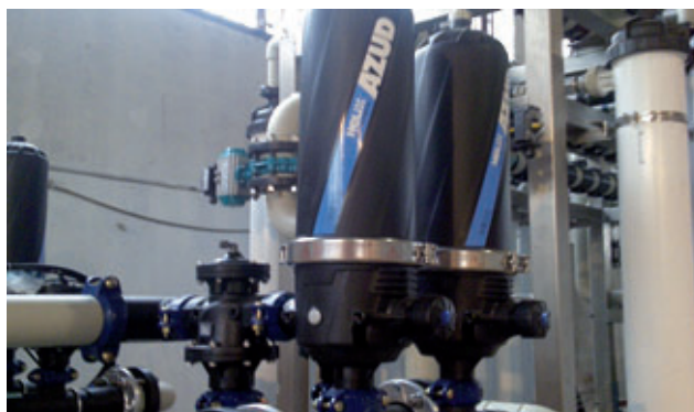
BÉLGICA BELGIUM | Central termoeléctrica Thermoelectric power plant
