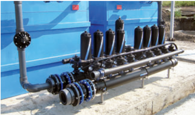
MOLDAVIA MOLDOVAN | Prefiltrado para UF UF prefiltration
